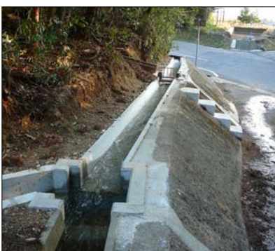
完成した小穴谷口井水改修
