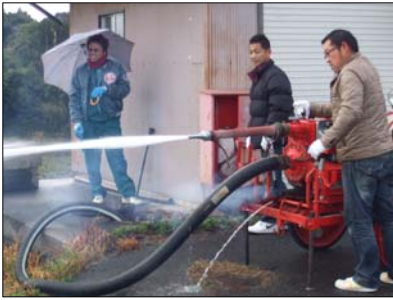
ポンプと消火栓点検の様子
